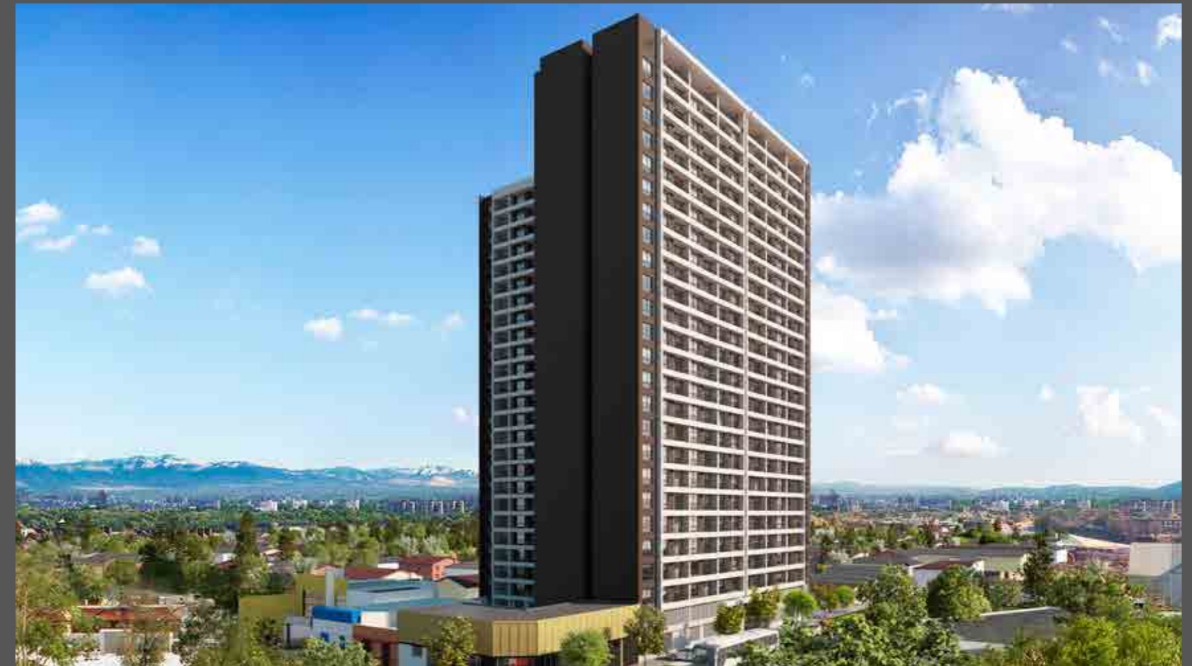
edificio ecoSANTIAGO | ESTACIÓN CENTRAL
